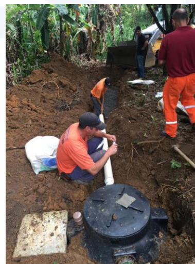
Instalação de fossas biodigestoras, em substituições a fossas negras.
