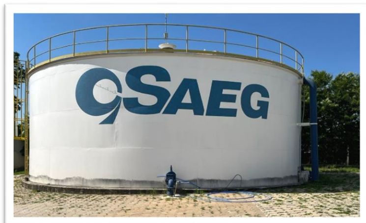
Reservatório localizado no bairro Village Santana
