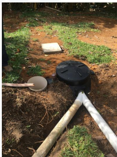
Instalação de fossas biodigestoras, em substituições a fossas negras.
